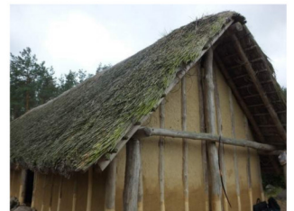
Pfähle dieses Gebäudes wurden in den vergangenen Monaten saniert. Foto: Martin Rieß
