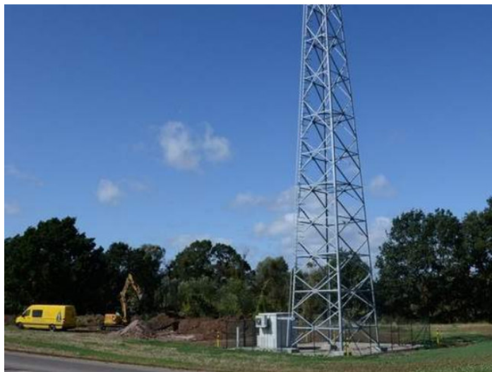
Der Funkturm für den Magdeburger Stadtteil Randau-Calenberge steht schon seit mehreren Wochen. Doch in Betrieb ist er noch nicht. Foto: Bianca Oldekamp
